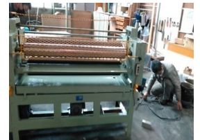
〈木工用糊付け機搬入・設置工事〉
