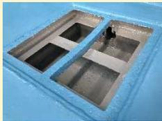
屋内温水プールの漏水があるとの事で、調査・止水工事を行いました。まず、プール排水溝からの漏水があり、こちらは枠内の枠内を、ウレタン塗料による防水工事を行いました。
