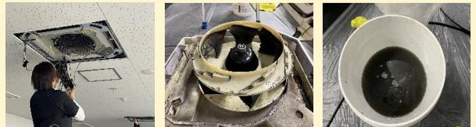
工場事務所のエアコンについて、フィルター清掃は行っているものの、内部洗浄は未実施とのことで調査を依頼されました。調査の結果、15年ほど前の機種で内部の汚れやカビが酷く、効率も低下していたため、稼働していない土曜日に6台一式の洗浄を実施しました。カバーや駆動モータ、ドレンポンプなど外せる部品を全て取り外し、内部洗浄・乾燥・クリーニングを行ったうえで組み立てて試運転を実施し、作業を完了しました。
