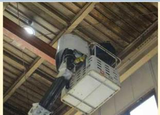
こちらは、ホイストクレーンの修理とチェーンの張り替え工事になります。ホイストクレーンのチェーンに劣化が生じていたため、チェーンの張り替えを実施しました。このような、ホイストクレーン、天井クレーン関係のメーカーが実施するような簡単な修理についてはお任せください。愛知県ならば迅速にかけつけますので、お気軽にご相談ください。
